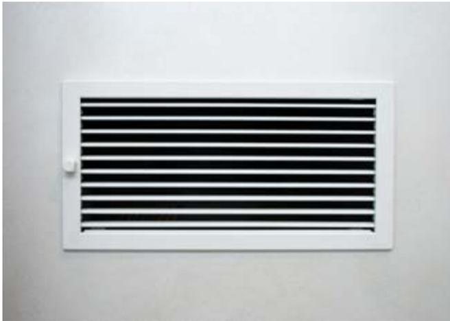
Abb. 16: Lüftungsgitter, geöffnet
