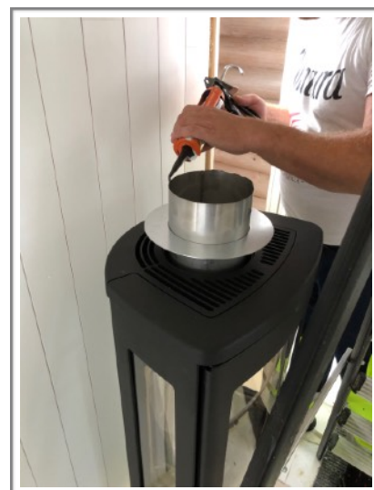
Kamiinan liitoksessa piippu asennetaan kantamaan sisäputkesta, jolloin piippumoduuli ei peitä kamiinan ilmakiertoa.
