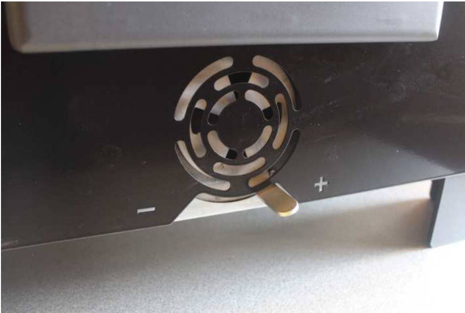
Kuva 4. Palamisilmansäätöritilä AUKI (+) asennossa
